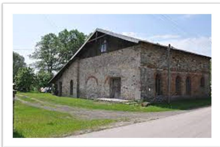
Fotografia 2. Pozostałości zakładu górniczo-metalurgicznego.
