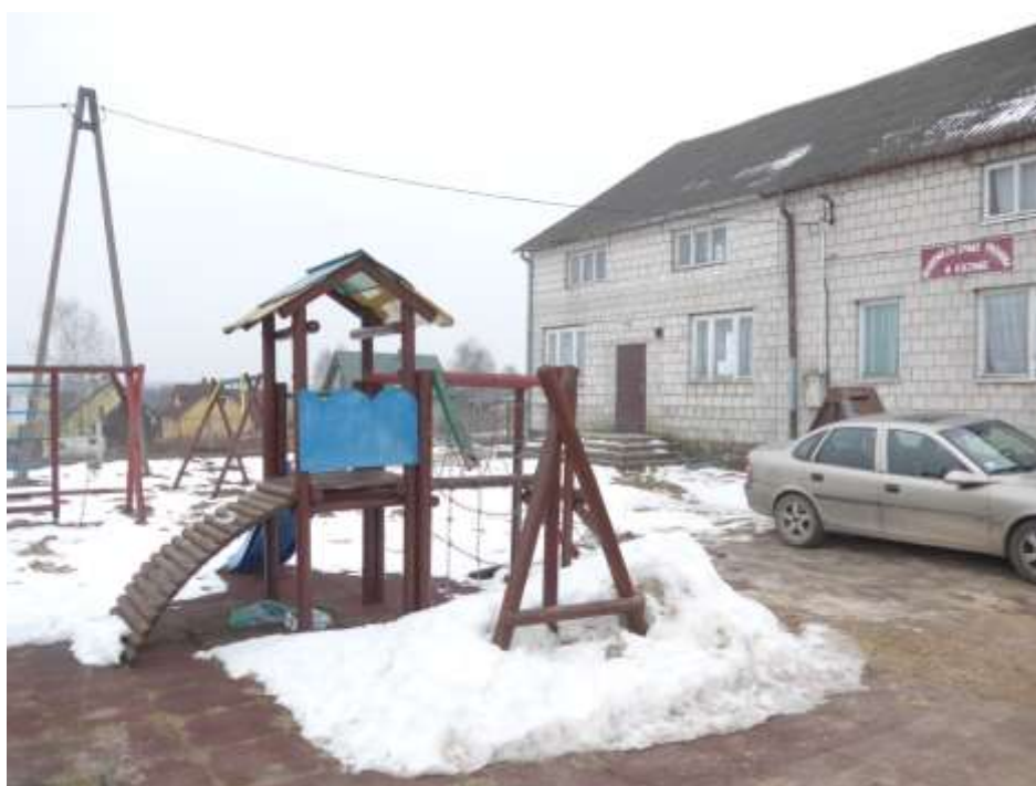
Zdjęcie 2: Budynek Ochotniczej Straży Pożarnej oraz plac zabaw w Kozowie – Fot: GRACZKOWSKI DOTACJE Sp. z o.o. luty 2015r.
