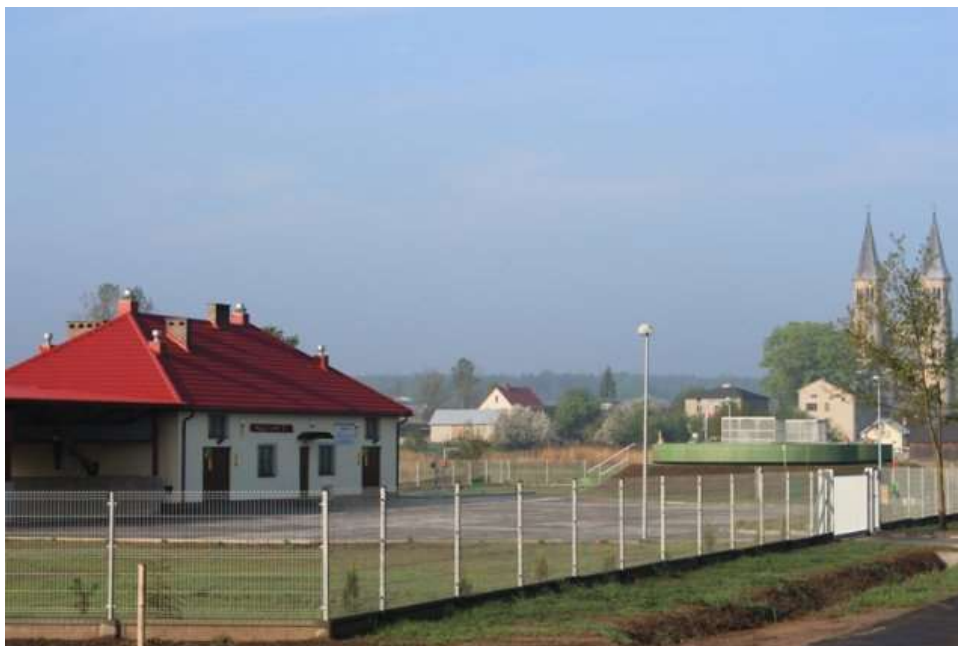
Zdjęcie 30: Oczyszczalnia ścieków w Miedzierzy. Źródło: http://www.smykow.pl/index.php?id=28&lan=pl
